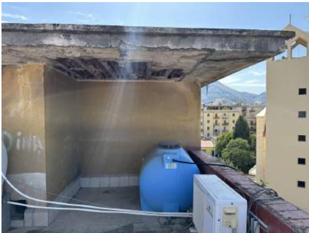
Foto 29 -Evidenti ammaloramenti dell'intradosso del solaio di copertutra del torrino e del frontalino
