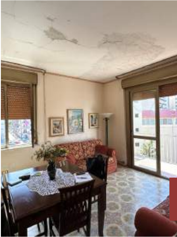
Foto 20 -Il soggiorno/pranzo ad angolo tra prospetti con finestra su Piazza S.G. Arcangelo, con balcone su area condominiale; importanti lesioni ed ammaloramenti sull'intradosso del solaio
