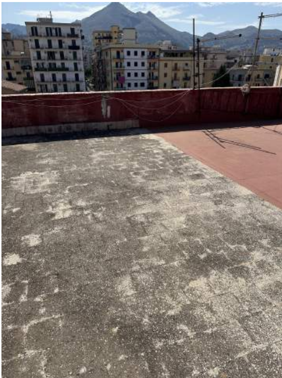
Foto 27 - La terrazza di copertura con rivestimento in mattoni di cemento, si nota un intervento di impermeabilizzazione con guaina per parte della superficie della stessa
